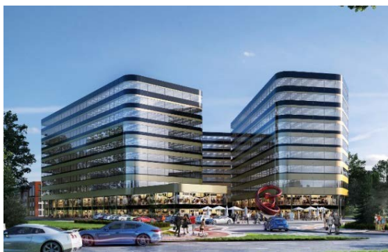
Fabryczna Office łącznie 39 tys. m 2
